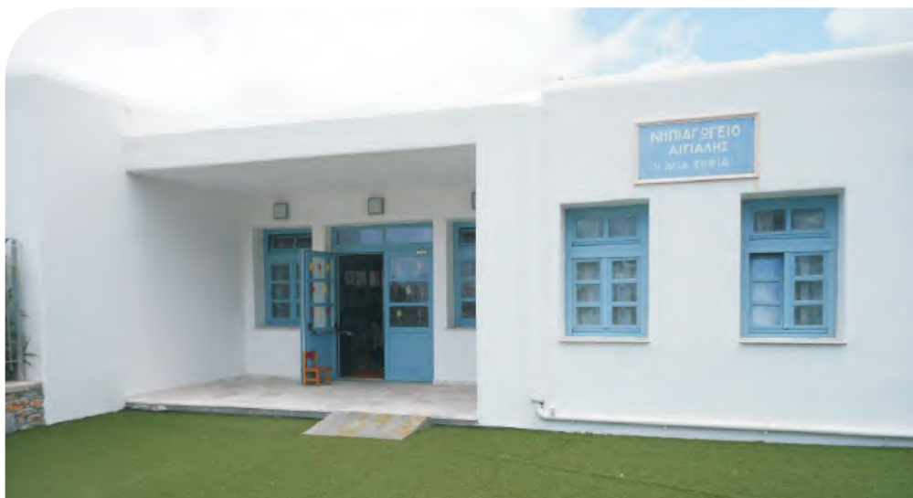
Δημοτικό Σχολείο και Νηπιαγωγείο Αιγιάλης Αμοργού
