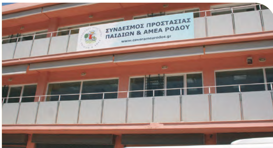
Στέγες Υποστηριζόμενης Διαβίωσης ΑμεΑ στη Ρόδο
