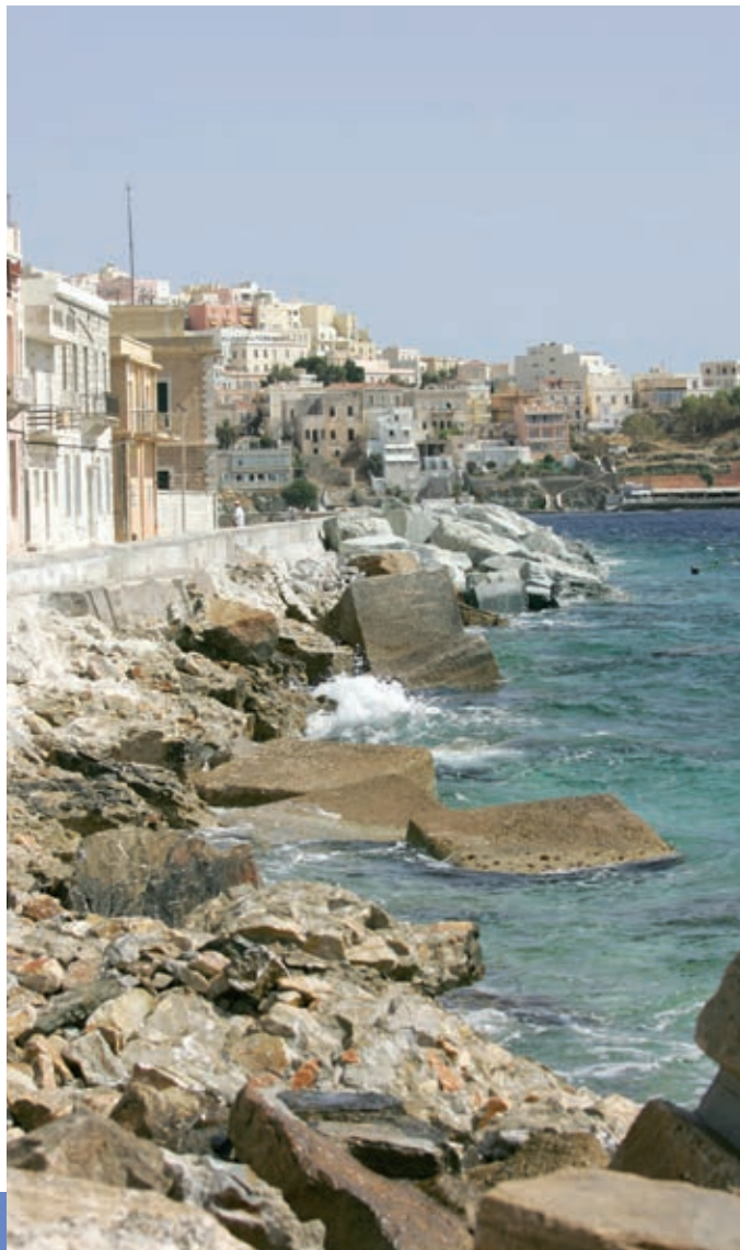
η κατάσταση του μόλου πριν το έργο
