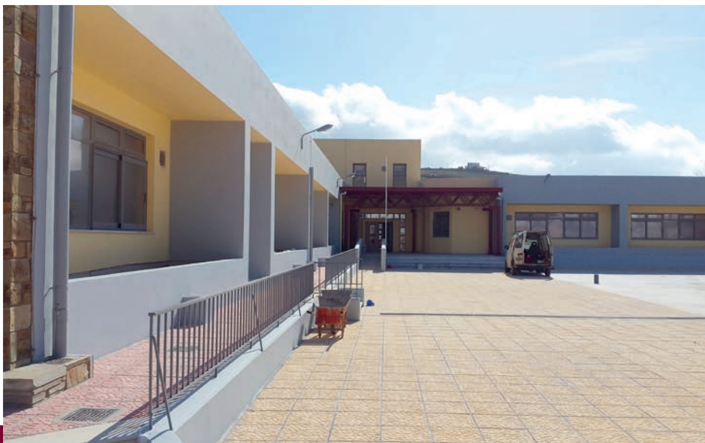
Το σχολείο στα τελικά στάδια των εργασιών, Φεβρουάριος 2015
